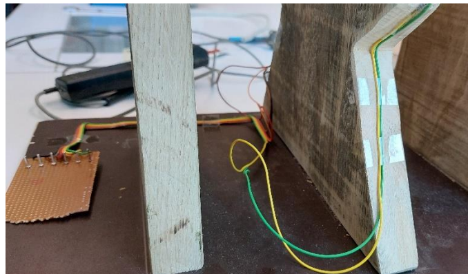
Abbildung 79: Verlegte Kabel von der Leiterplatte zu den Spulen (Eigene Abbildung)
